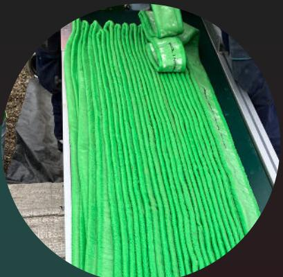
La gaine est imprégnée de la résine sur toute sa longueur à l'aide de la table d'imprégnation puis son installation est réalisée avec un tambour de réversion et de l'air comprimé
